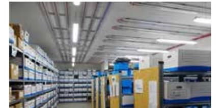
Die Montage erfolgt normal auf Konterlattung oder Tragprofile, um mit weniger Bohrlöchern auszukommen. Wenn es um jeden Millimeter geht, lassen sich die Profile auch direkt an die Decke montieren (ab 30 mm Aufbauhöhe). Die Rohre werden in die Sicke der Profile gedrückt.
