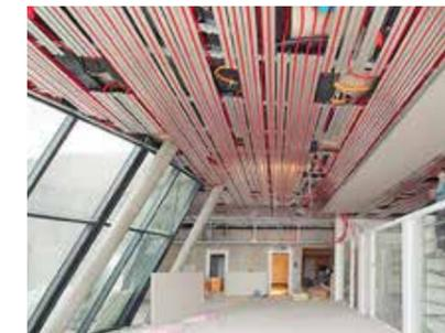
Die Klimadecke kann beliebig tief abgehängt werden. Auch eine kurze Abhängung kann manchmal sinnvoll sein, um zum Beispiel Unebenheiten der Rohdecke auszugleichen. Die abgehängte Klimadecke für die WU-Wien wurde vor Ort präzise auf die komplexe Geometrie der Decke zugeschnitten und erzielt so eine Belegungsichte, die mit vorgefertigten Kassetten nicht möglich wäre.
