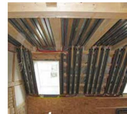
Bei Satteldächern können die Wärmeleitprofile auch Dachschrägen und Wände für den Heiz- und Kühlbetrieb aktivieren. Das ermöglicht eine hohe Belegungsichte, um die Leistung und Effizienz zu steigern. Werden die Profile zwischen Holzbalken montiert, stehen diese nach der Beplankung noch sichtbar hervor. Das erhält die Raumhöhe und die originale Deckenuntersicht, was auch dem Denkmalschutz entgegenkommt.
